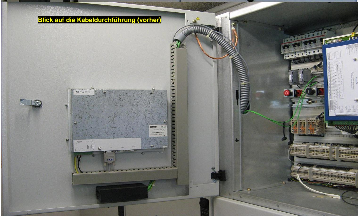
**Bedieneinheit CMP System Line ausgebaut**
